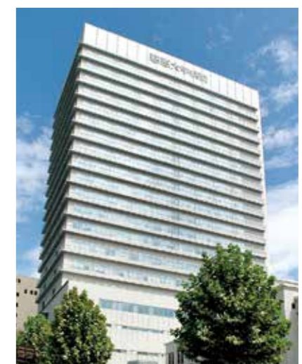
附属病院(本院)中央棟
