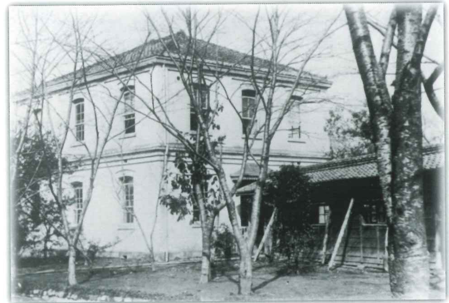
鹿鳴館慈善バザーで建てられた看護婦教育所（明治18年）
