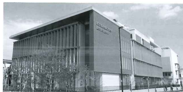
▲増改築後の校舎外観
